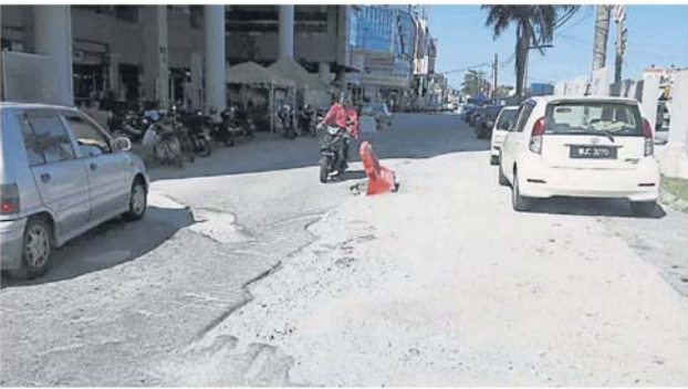
坑洞四伏，为免公路使用者撞落坑，善心人士在洞旁置路障警告公众。
